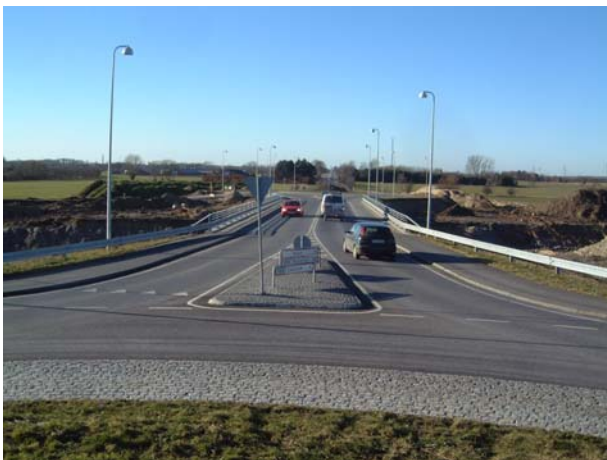
Ny bro på Fyn udført i september 2003. Brodækket er støbt med traditionel kvalitetsbeton
