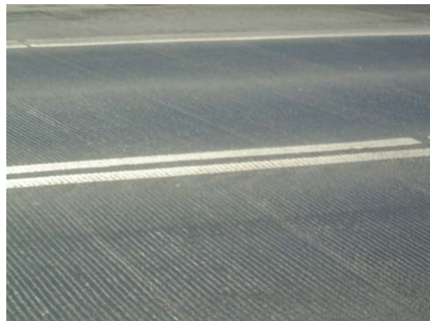
Oven på den traditionelle beton er der udlagt 40 mm Latexmodificeret beton. Overfladen er riflet for at sikre god friktion.
